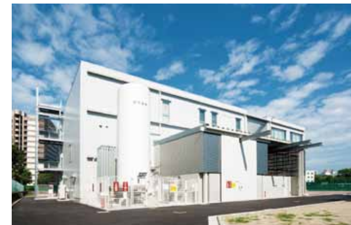
地上3階建ての窒化物半導体マルチビジネス創生センター外観
